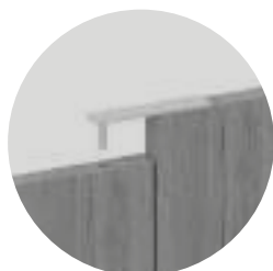
Système de liaison entre les panneaux rectangulaires
